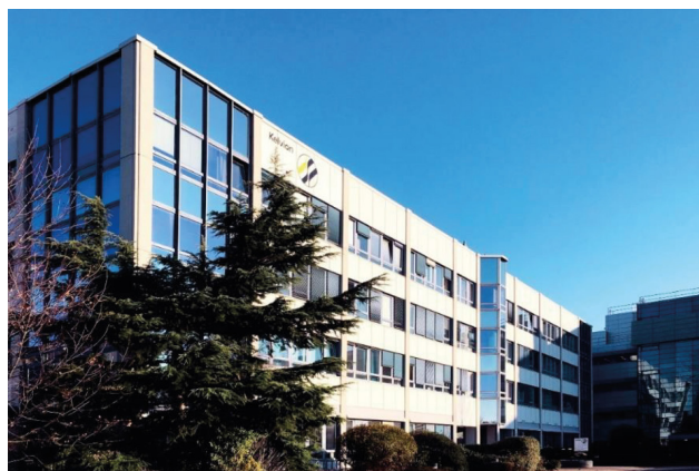
Abbildung 1: Blick auf die Hauptzentrale der Kelvion Holding GmbH in Bochum. (Foto: Kelvion)
